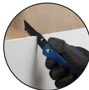
LA LAME DENTELÉE COUPE LA MAILLE DES PANNEAUX DE CIMENT
